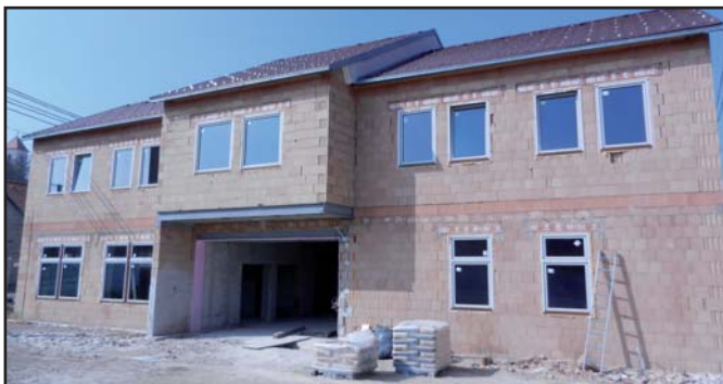
Stavební práce na nové budově obecního úřadu pokračují dle schváleného harmonogramu. V těchto dnech byly dokončeny vnitřní omítky a zahájeno betonování podlah.
