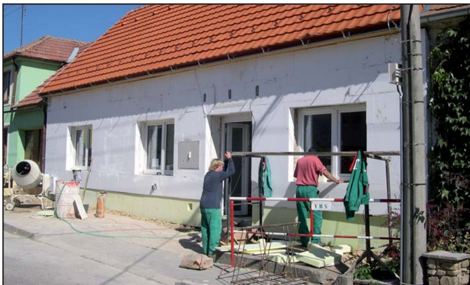
V druhé polovině září finišovaly stavební práce na opravě budovy pošty a kadeřnictví
