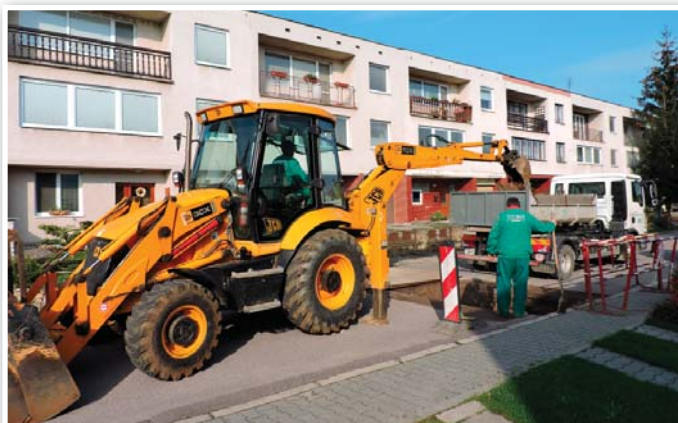
Oprava dešťové kanalizace
