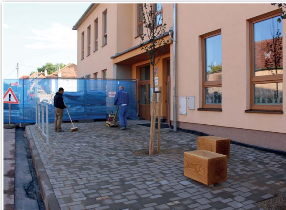
Stavební práce ve škole úspěšně pokračují
