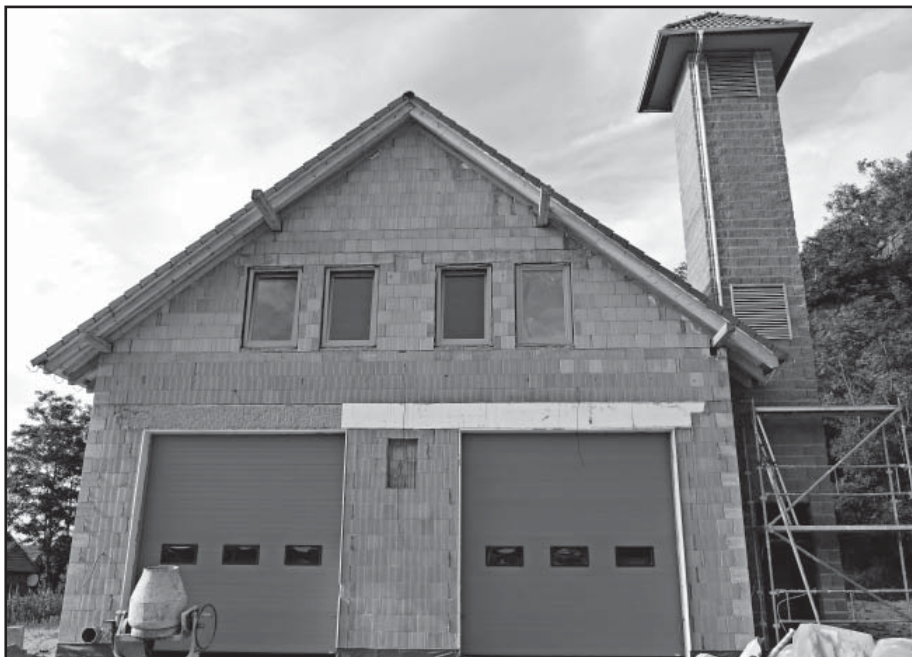
Hrubá stavba hasičárny
