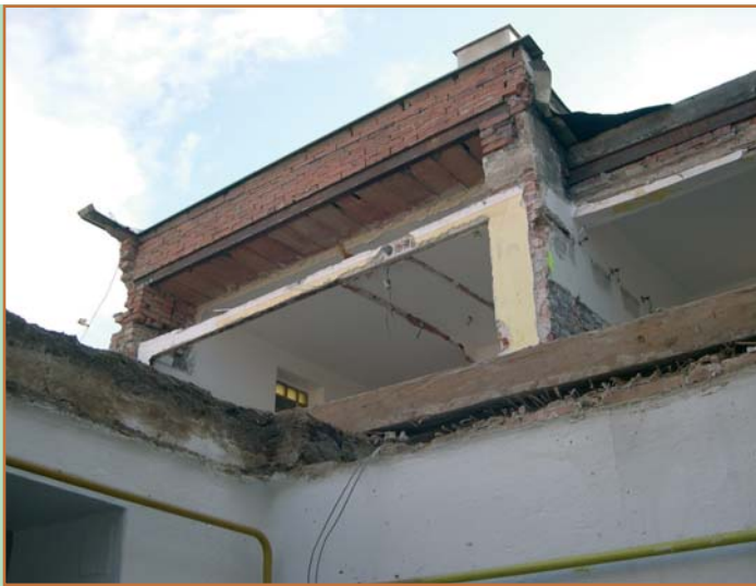
Přestavba školky začala bouráním staré části budovy
