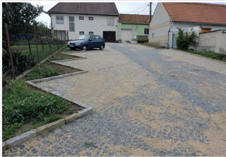
V obci bylo postaveno nové parkoviště
