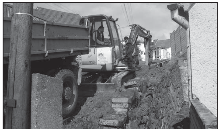
Stavební práce na propojení vodovodu pokračovaly velmi rychle
